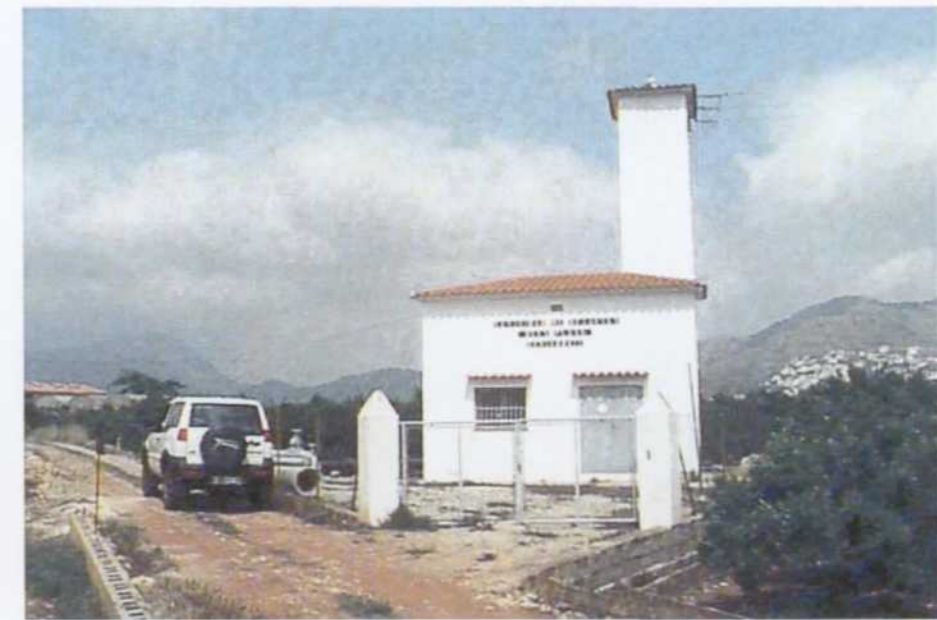
Sondeo en explotación de la Comunidad de Les Plans.
